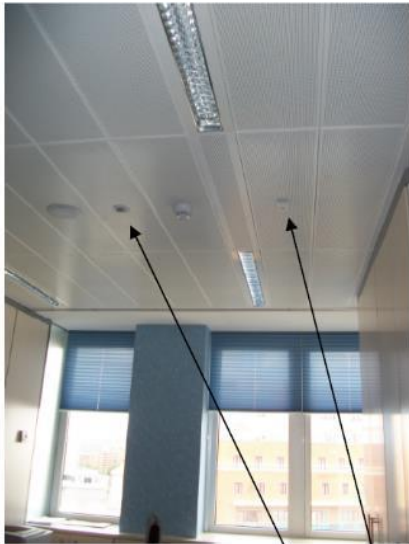
Ejemplo de ubicación de los sensores de presencia y luminosidad en el despacho nº 9
